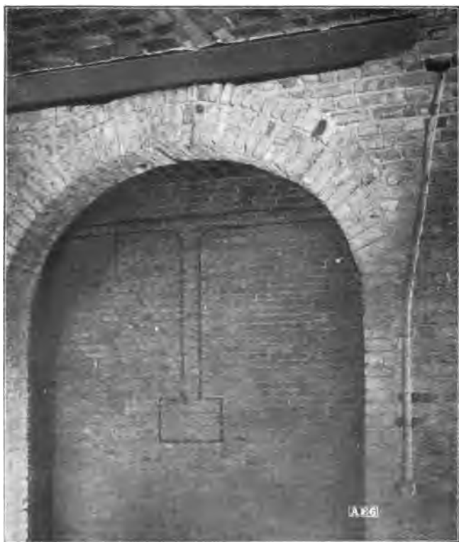
Fig. 18. Nicho dibujado para el cuadro de distribución y canal del tubo. A la derecha un canal abierto para el alambre.
