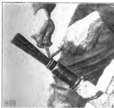
Fig. 95. Cortando el relleno de yute sin apoyarse en el aislamiento interior.
