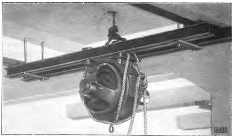
Fig. 10. El motor toca á las vigas y se atornilla.
