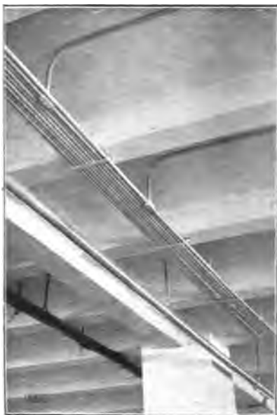
Fig. 62. Tubos acorazados al descubierto conduciendo la luz en el techo.
