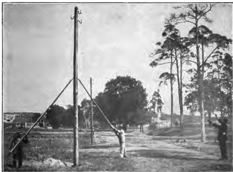
Fig. 136. Colocando el poste con la plomada.
