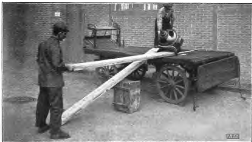
Fig. 5. Al descargar el motor se vuelca un poco para poder poner los tablones debajo.
