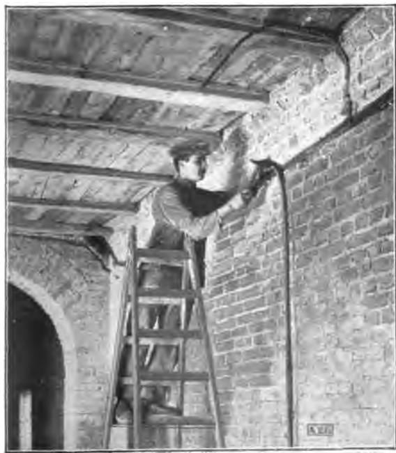
Fig. 25. Instalaci3n del tubo de goma endurecido, fijaci3n por medio de puntas.
