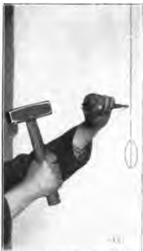
Fig. 10. Al lado de la linea marcada se introducen las espigas de acero en la pared con ayuda de un punzón.
