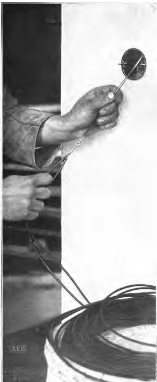
Fig. 28. Tirando de la cinta se va introduciendo el alambre conductor.
