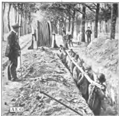
Fig. 73. Colocando un cable subteraneo de alta tensión en una zanja.
