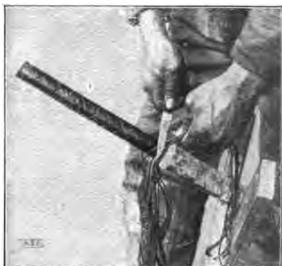
Fig. 90. Cortando el revestimiento de yute interior, cortar hacia afuera
