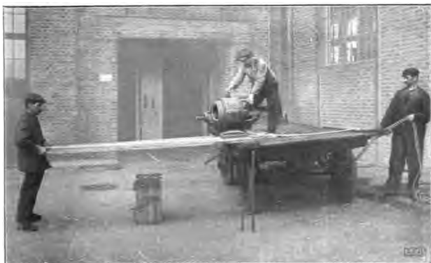
Fig. 6. Cuando está el motor encima de los tablones se baja la extremidad opuesta procurando tener bien tensa la cuerda de sujeción.
