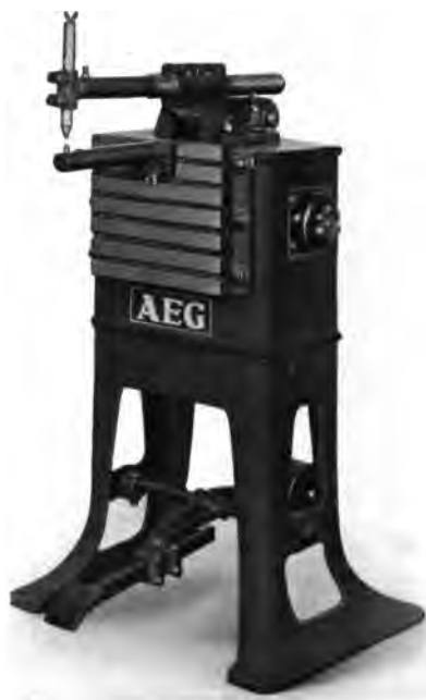
Máquina para soldar por puntos de accionamiento por pedal.
