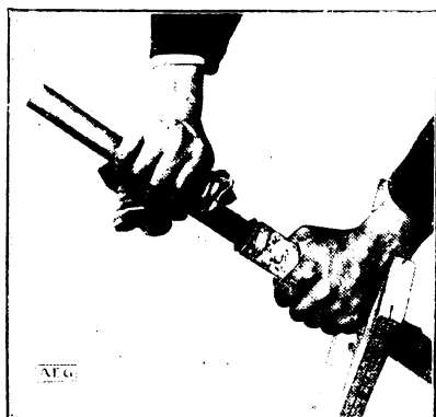
Fig. 91. Limpiando el tubo de plomo con bencina.
