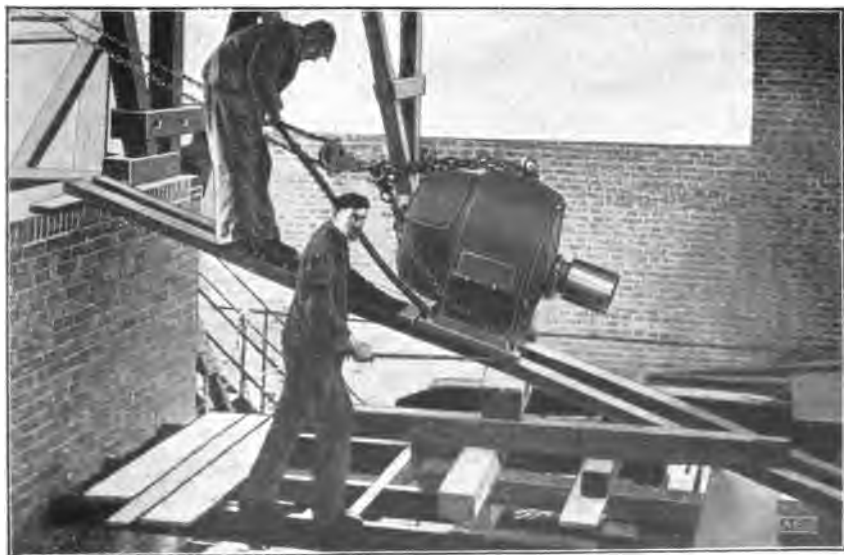
Fig. 8. Transporte inclinado de un motor pesado. Este despues de sujeto por una cadena doble, se levanta ó sostiene con un aparejo diferencial.
