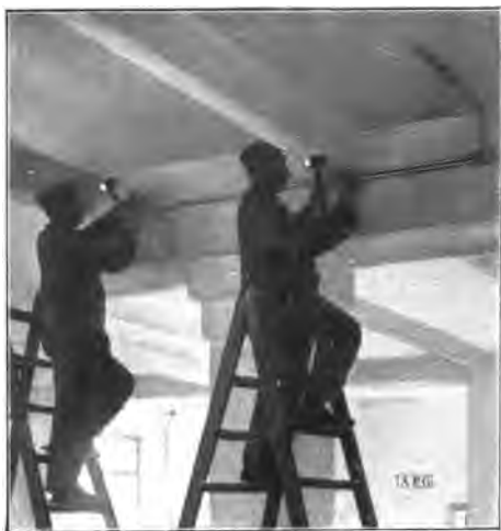
Fig. 11. Al lado de un tubo de aislamiento pueden clavarse las espigas sin otra preparación.
