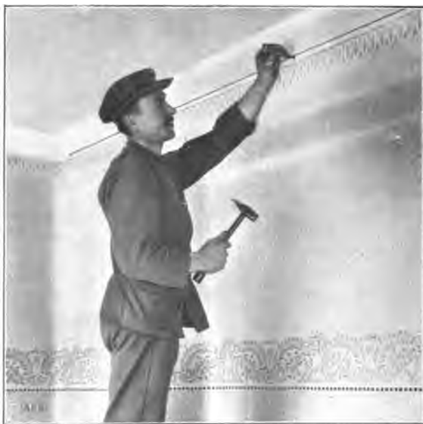
Fig. 46. Al lado de un cordón tirante se colocan las espigas de acero.
