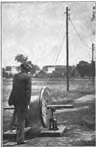
Fig. 149. Bobina de alambre colocada en forma de torno sobre dos caballetes; á la izquierda se ve un pedal de madera que sirve de freno.
