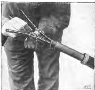
Fig. 96. El extremo del cable despues de separado el aislamiento.
