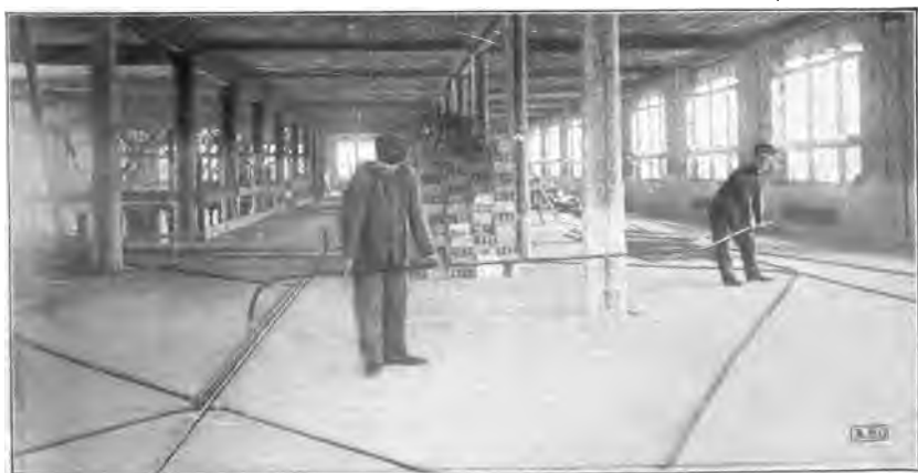
Fig. 68. Colocando los tubos en el suelo superior al techo.
