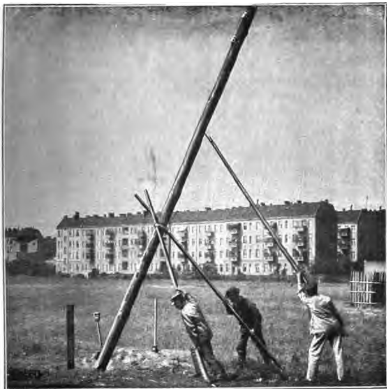
Fig. 135. Levantando el poste.
