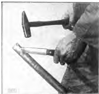
Fig. 92. Cortando el tubo de plomo con un cuchillo tangencialmente al aislamiento interior.
