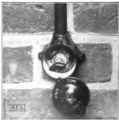
Fig. 64. Instalación terminada con su llave y caja de derivación.
