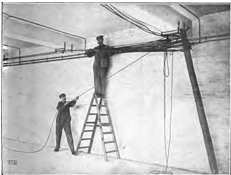
Fig. 127. Los hilos y al principio que estaban sueltos sobre las poleas se atirantan aprovechando un punto de fijación provisional.
