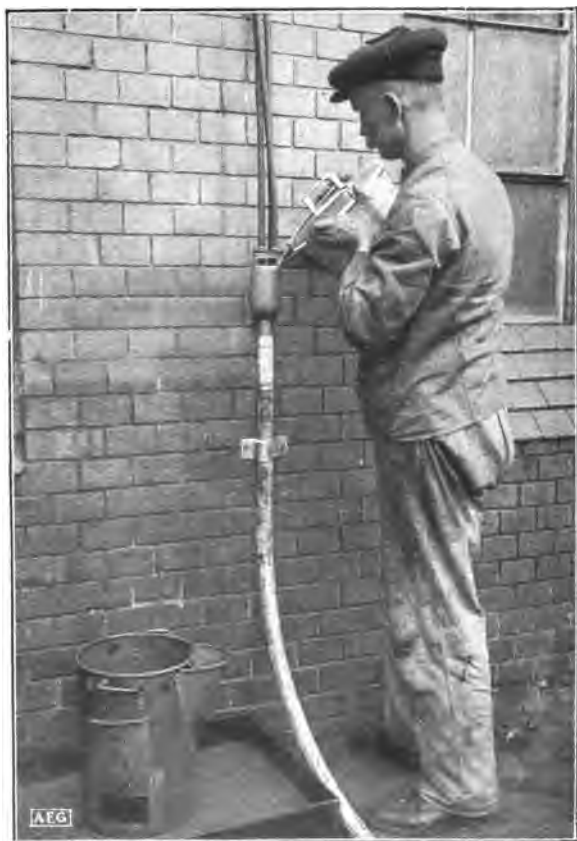
Fig. 99. Calentando la masa aislante en una estufa de palastro colocada en una caja de arena para evitar el peligro de incendio. Vertiendo la masa en el terminal de palastro.
