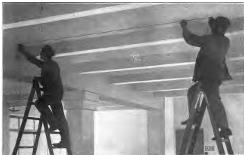
Fig. 9. Un cordón untado de tiza ó de carbón es sujetado por sus extremidades y cogido por enmedio y soldado marca la linea en el techo.
