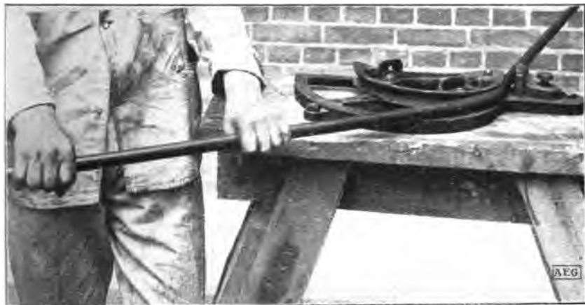
Fig. 60. Doblando el tubo protector de acero con el aparato de plegar.
