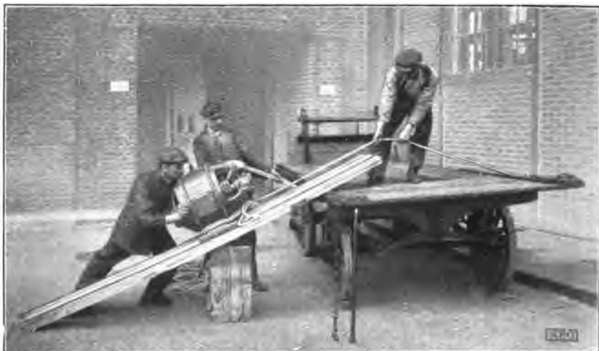
Fig. 4. Cargando un motor en un carro. Sobre las pletinas de hierro colocadas encima de los tablones asciende facilmente el motor cuando el obrero tira de la cuerda.
