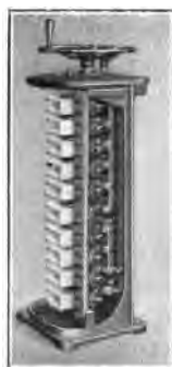
Fig. 3. Conmutador de maniobra.
