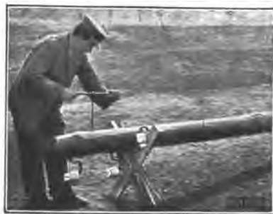
Fig. 134. Atornillando los aisladores al poste tendido.
