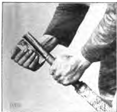
Fig. 93. Arrancando el tubo de plomo.
