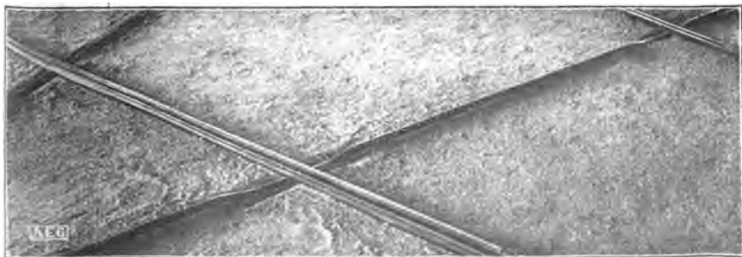
Fig. 66. Cruce de dos tubos sobre la capa de hormigón.
