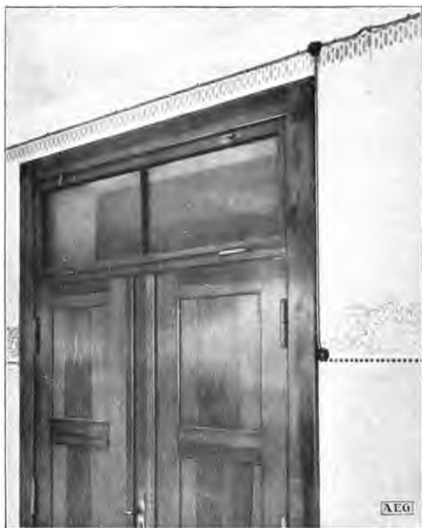
Fig. 49. Derivación y bajada de llave en el recuadro de una puerta.
