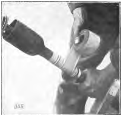
Fig. 98. Ajuste del embudo de la caja terminal al tubo de plomo fijandola con cinta aislante.
