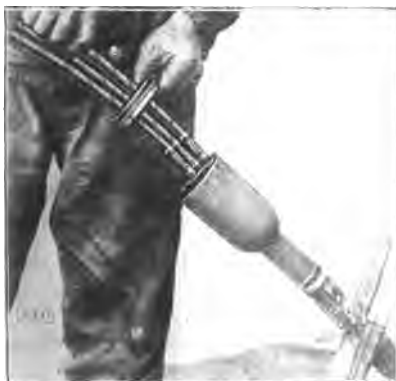
Fig. 97. Colocando la tapa de la caja.
