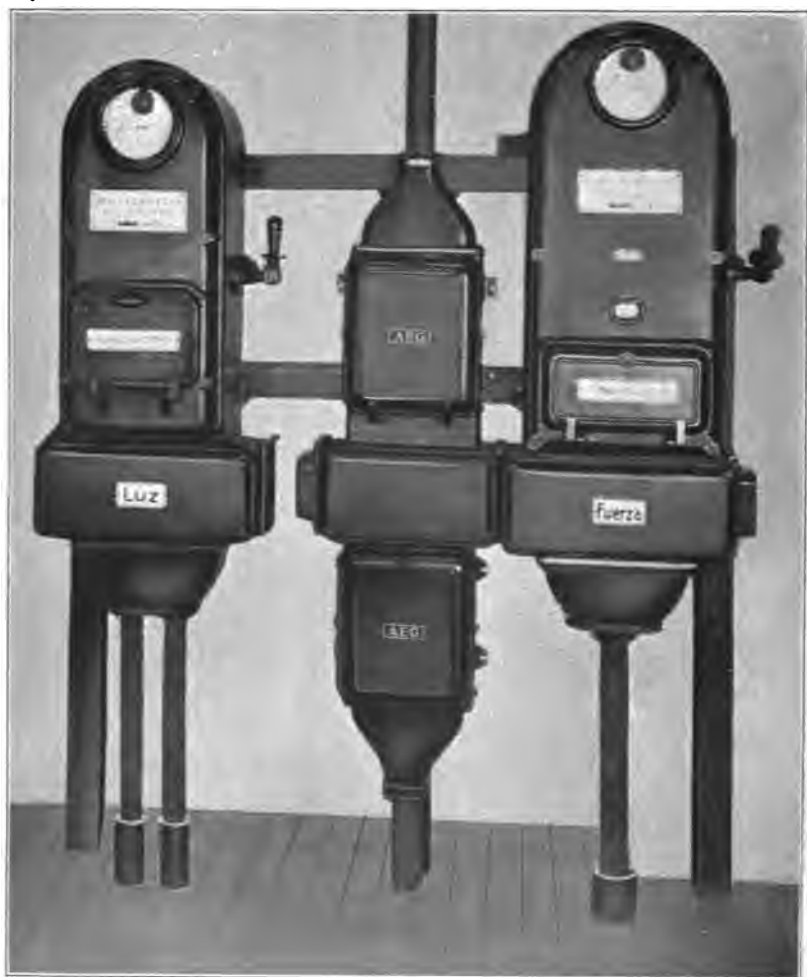
Fig. 106. Instalación terminada de aparatos protegidos para distribución de energía.
