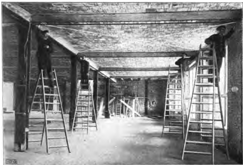
Fig. 67. Marcando con cuerdas el sitio del sitio del techo donde debe perforarse.
