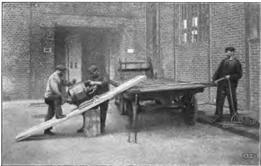
Fig. 7. El motor se desliza al soltar poco á poco la cuerda, cuando se levanta ligeramente el borde inferior de la base.
