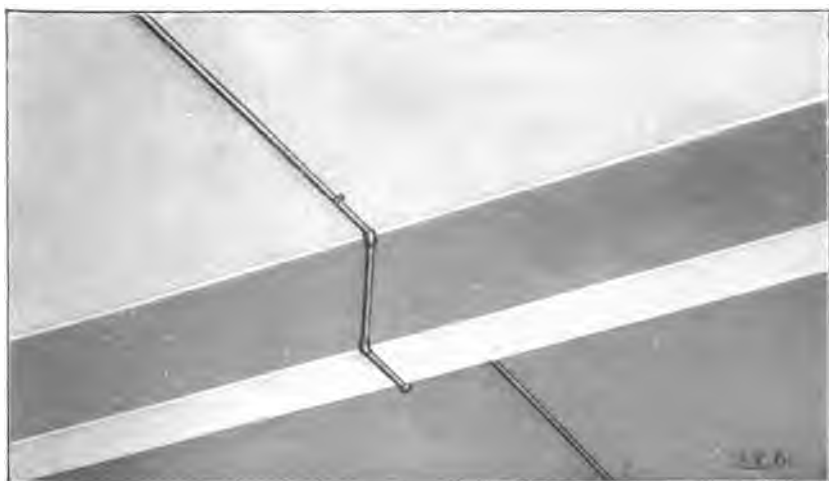
Fig. 15. Al pasar por encima de una viga no se puede evitar la forma en U del tubo. Aquí se necesita piezas angulares desmontables para sacar el agua que se depositase.
