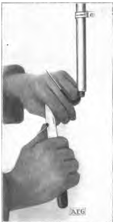
Fig. 29. Corte transversal falso de la capa aisladora.
