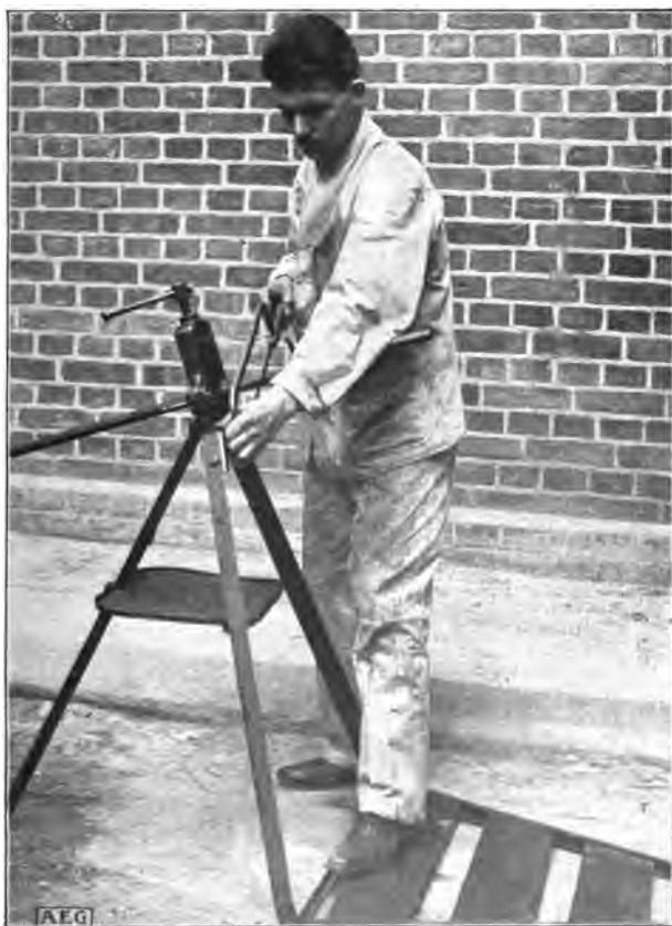
Fig. 55. Para trabajar los tubos protectores lo mejor es un tornillo portátil especial.
