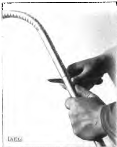
Fig. 5. Corte del tubo aislador.
