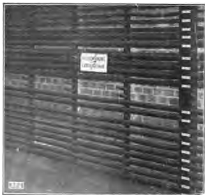
Fig. 74 Cables en el muro de un tunel sujetos con sopores de fleje de hierro en forma de gancho.
