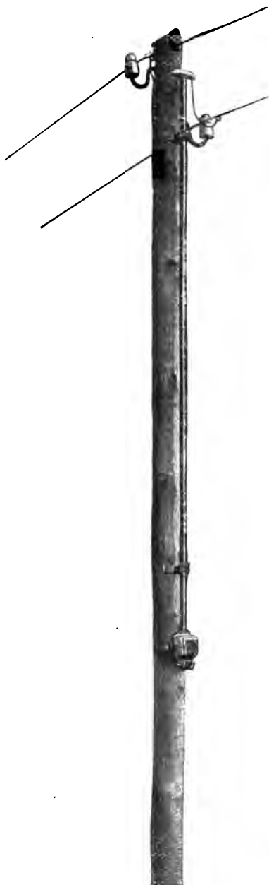
Fig. 163. Soporte tubular para bajar el conductor á la caja de enchufe.
