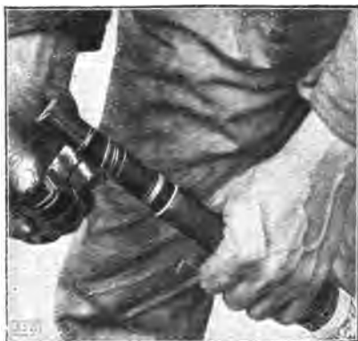
Fig. 94. Arranque del aislamiento de papel sujeto previamente por un bramante en el borde del tubo de plomo.
