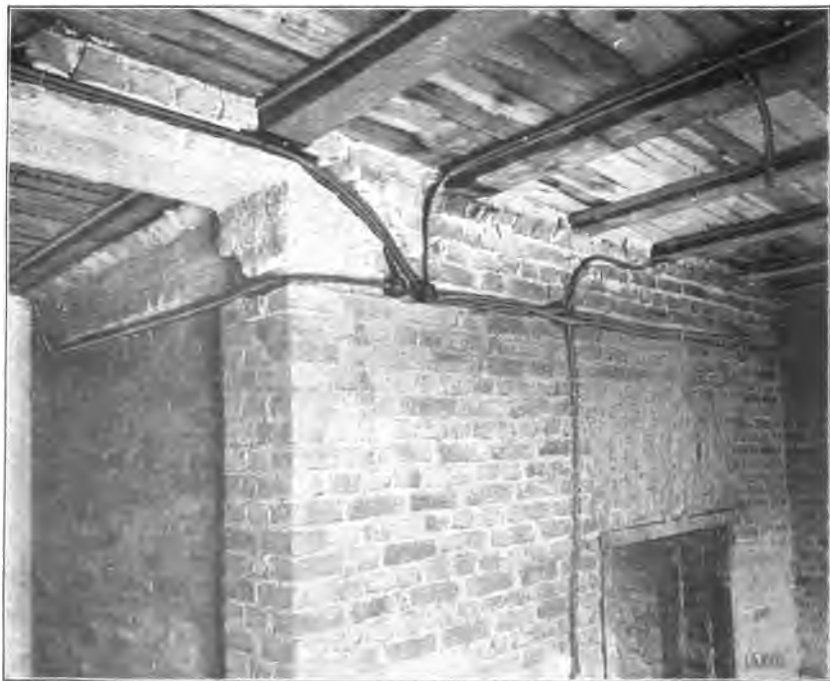
Fig. 27. Instalación terminada antes del enlucido. (Tubo caucho endurecido.)
