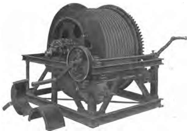
Fig. 4. Torno con sistema de anillos rozantes.
