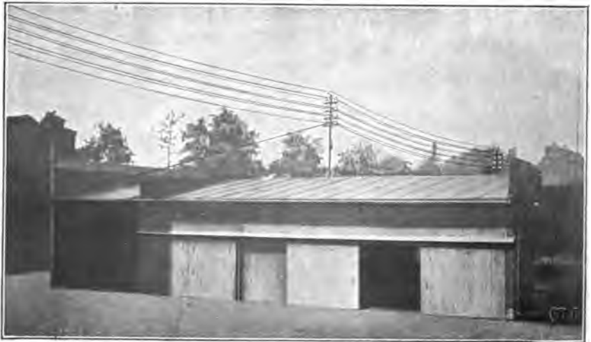
Fig. 145. Soporte para aisladores de tejados (ninguno de los hilos puede alcanzarse desde el techo).
