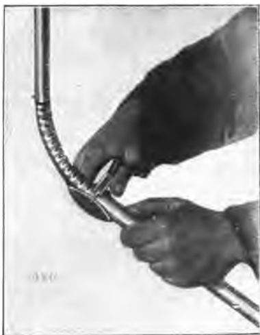
Fig. 3. Curvado del tubo aislador.
