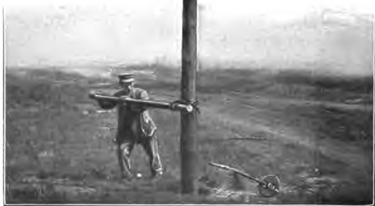
Fig. 137. Introduciendo el poste en un agujero barrenado.
