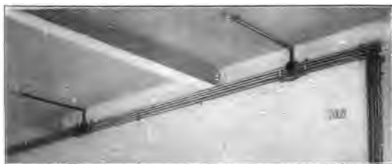
Fig. 16. Instalación defectuosa de los tubos debajo de la caja de distribución (los tres tubos de abajo forman „depósito de agua“).
